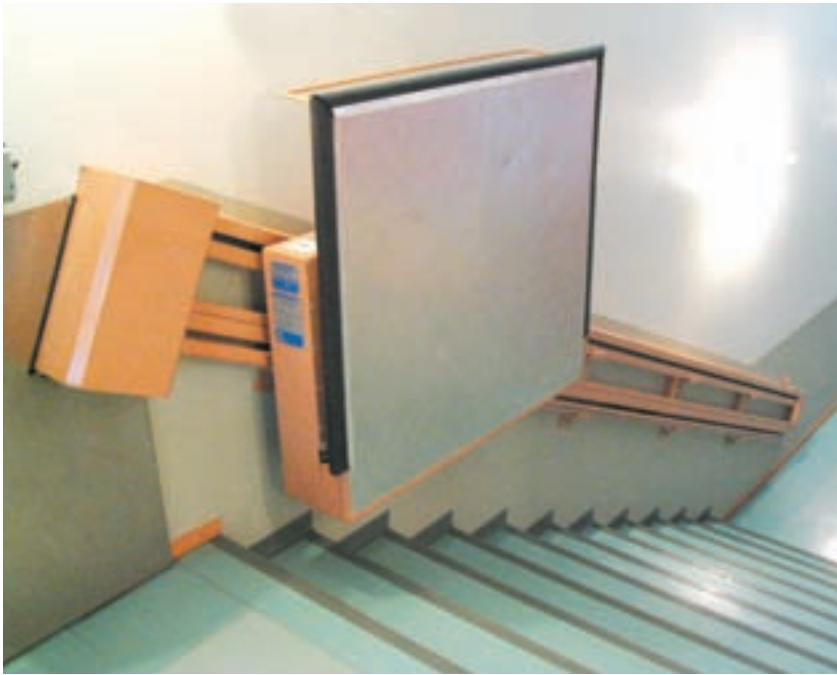
Kuva 12 Kahden kerroksen välillä oleva pyörätuolihissi
